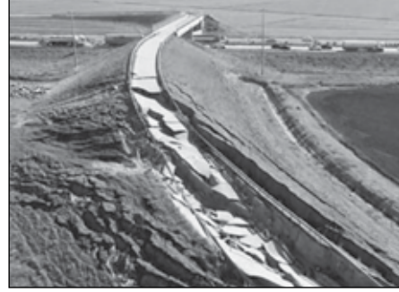
شقوت ضخمة في الطرق السريعة (كهرمان-تركيا)، في أعقاب زلزال شباط ٢٠٢٣
