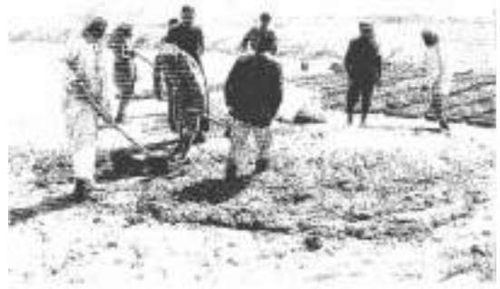
الصورة ٤: عملية تحضير الطين المخصص لصناعة اللبن.
